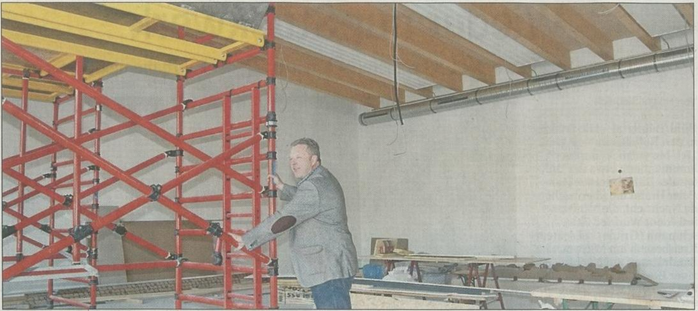
Noch steht das Gerüst für die Innenverkleidung: Stadtkapellenchef Marc Schneider im neuen Probenraum.
