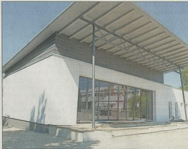
Viel Eigenarbeit haben die Mitglieder der Stadtkapelle in das neue Bühnengebäude investiert.
